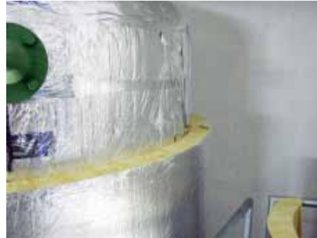
Ein gut gedämmter Pufferspeicher erhöht wesentlich die Effizienz der Heizungsanlage
