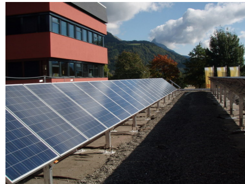
Das „Sonnenkraftwerk Rathaus“
